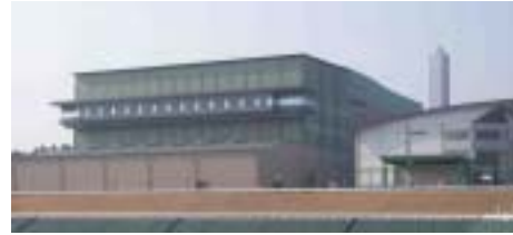
焼却溶融施設
