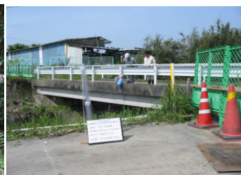
石崎川無名橋
