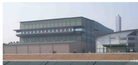
焼却溶融施設
