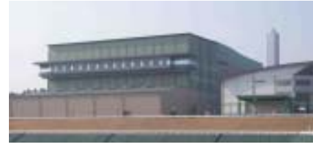
焼却溶融施設
