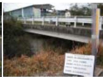
石崎川無名橋
