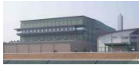
焼却溶融施設
