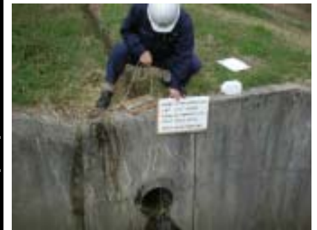
浸出水調整池地下水
