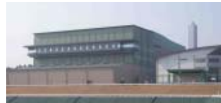
焼却溶融施設
