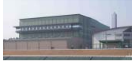
焼却溶融施設
