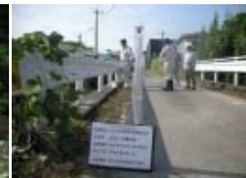
石崎川無名橋
