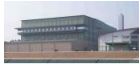
焼却溶融施設
