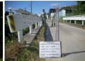
石崎川無名橋
