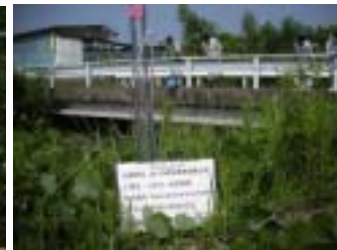
石崎川無名橋
