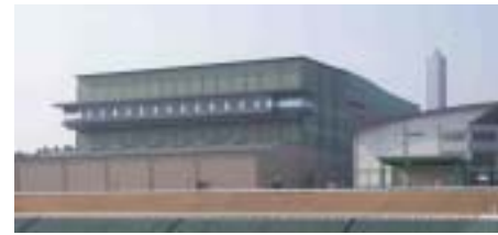
焼却溶融施設
