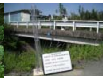
石崎川無名橋
