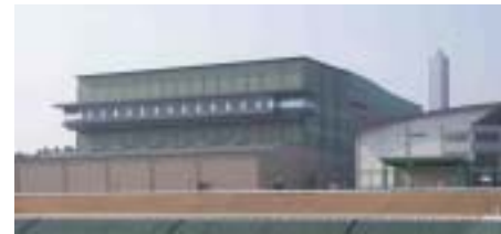
焼却溶融施設
