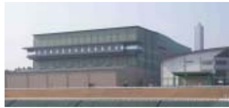
焼却溶融施設
