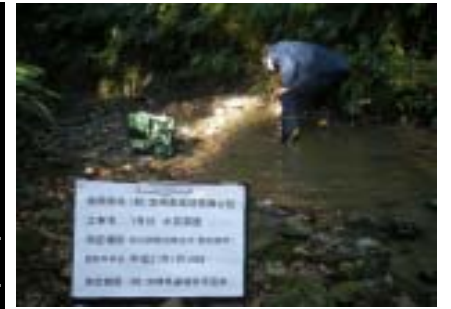
防災調整池排水(敷地境界)
