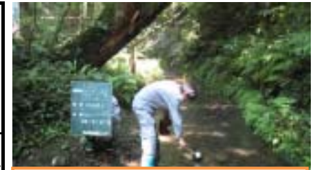
防災調整池排水(敷地境界)
