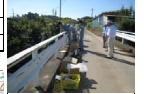
石崎川無名橋
